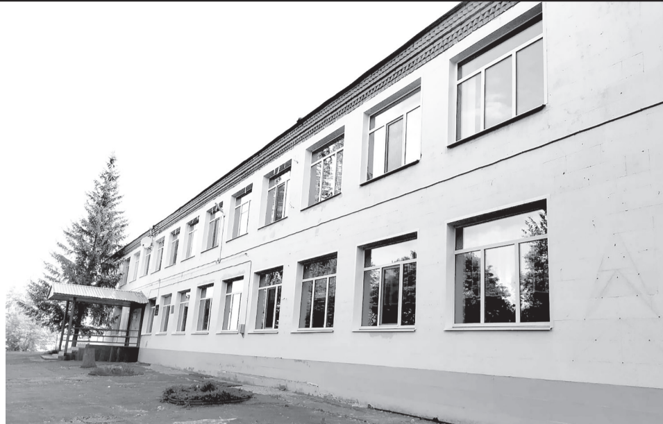
Школа после ремонта открывает свои двери
